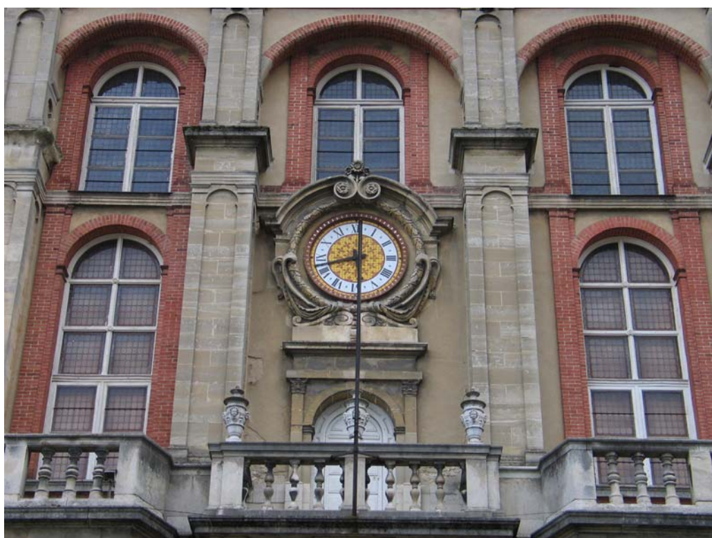
Ill. 51. Quelques fenêtres de la salle de Bal au premier étage du château de Saint-Germain-en-Laye, cliché F. Hervé.
