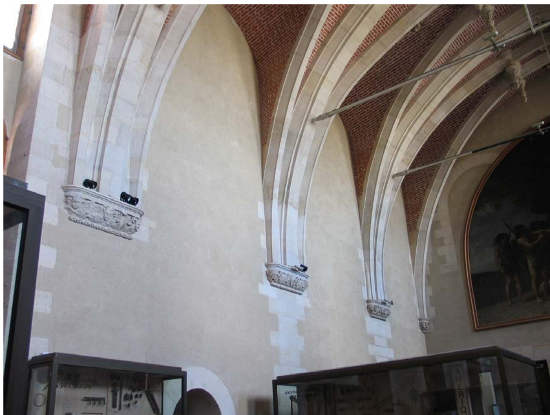
Ill. 57. Les arcades de pierre et les compartiments du brique du plafond de la salle de Mars, cliché F. Hervé.
