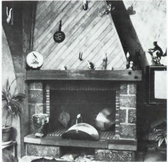
3. La réalisation de cette cheminée a conduit son auteur à faire tailler le granit cédé par un carrier de la région. Les briques ont été achetées à Mende, la poutre en châtaignier récupérée sur un chantier de travail; le pin également. Les gros clous ont été forgés par lui. Photo Ph. Bonnin.
