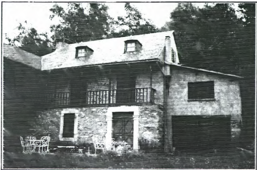
Même maison : garage ajouté avec une chambre construite au-dessus pour les enfants. Abreuvoir transformé en jardinière, pierre de cuveau à lessive aménagée en siège. Grange devenue salon.
