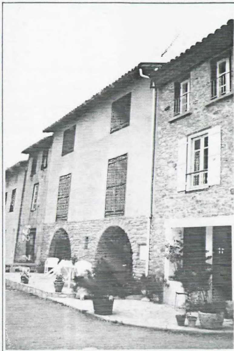
Montségur. Deux types de restauration (façades sur l'arrière) avec balisage de l'espace privé-privé sur le passage privé-public.
