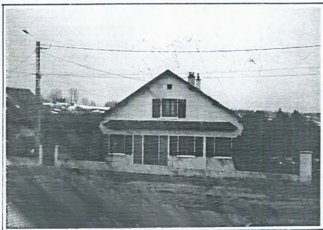
Le "retour au pays" sans héritage. Maison de lotissement, achetée en 1974 par M. et Mme Vayssère qui y vivent depuis leur retraite, en alternance avec Paris. Aubrac lozérien, avril 1994.
