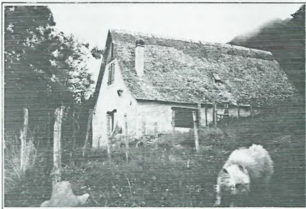
Marsous, une grange aménagée "lère génération" : les ouvertures sont agrandies, le jardin clos de fils barbelés et une clôture électrique, le toit est percé pour éclairer les combles.
