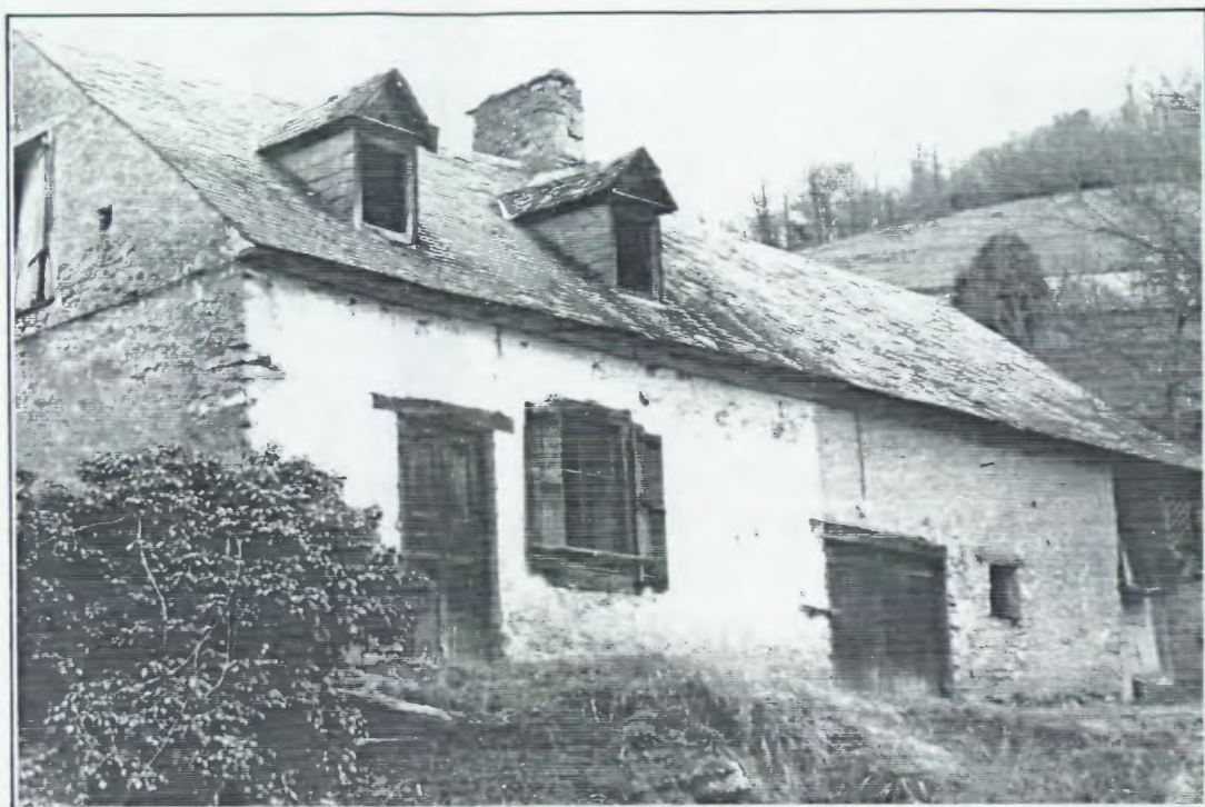
1973 : une maison non encore restaurée
