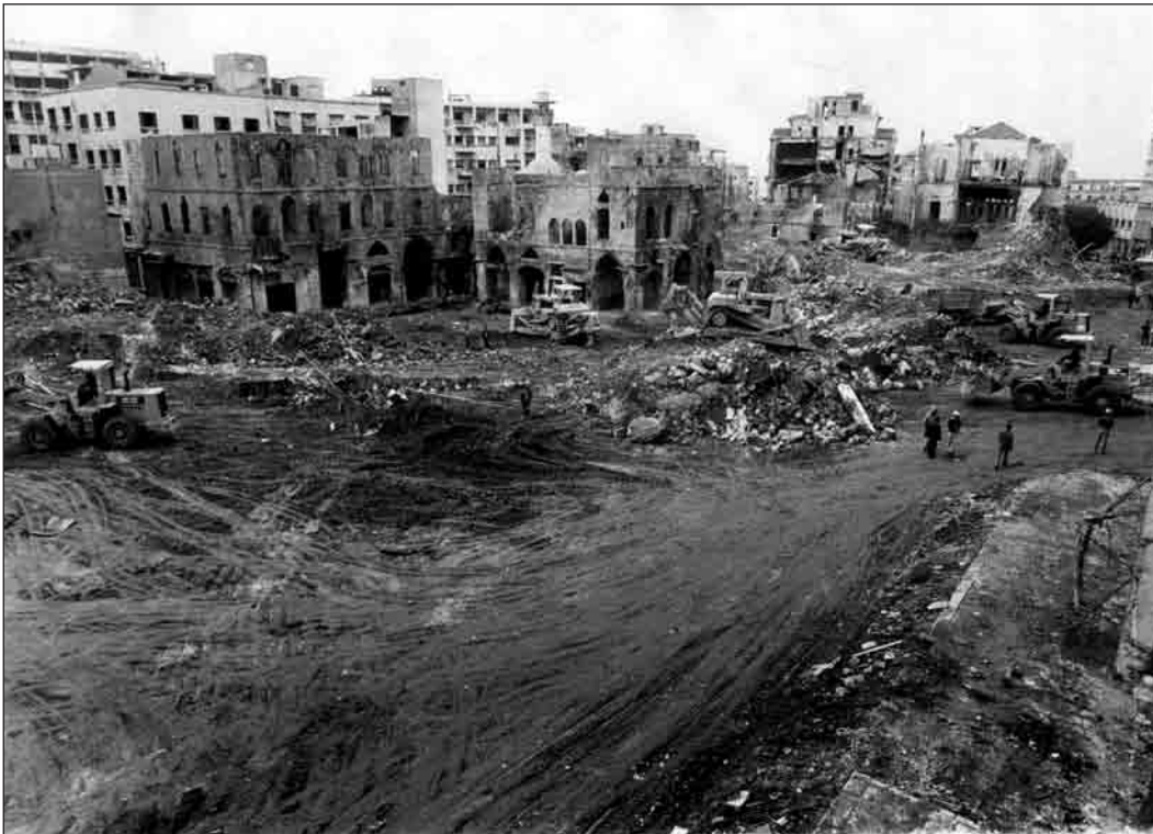
Les bulldozers d'OGER Liban arrasant les ruines des souks du centre-ville de Beyrouth dont la réhabilitation était pourtant prévue, 15 janvier 1983.
