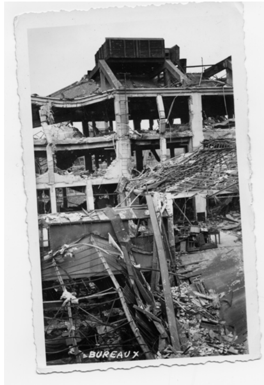
Figure 6 : Image du bâtiment A5, bureau d'études (avril 1943)
