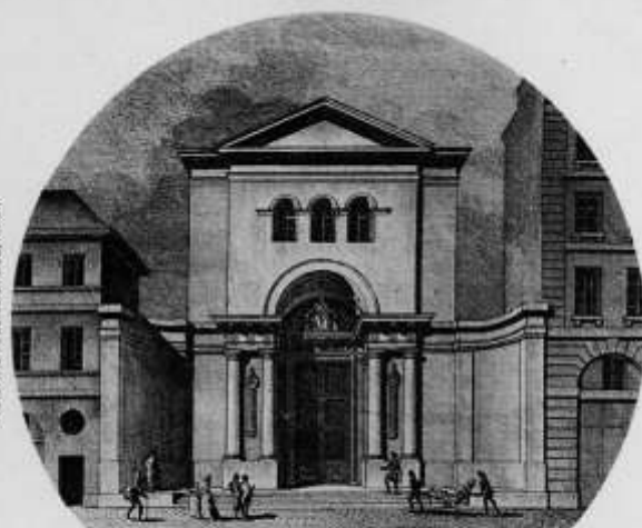
ÉCOLE DE MÉDECINE Rue des Saints-Pères PAR CL. BARBEAU CL. LINTOIS ARCHITECTE.
