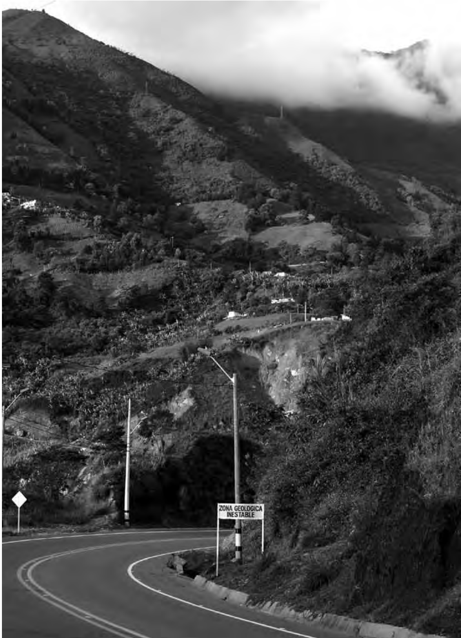
FIG. 11. Santafé de Antioquia, Antioquia (abril de 2008). La carretera al Mar. La señal de tránsito, abajo al centro, advierte que se trata de una “zona geológica inestable” Fuente: Fotografía del autor
