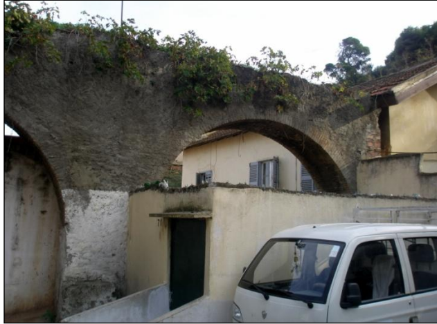
Fig. 6. Vestiges de l'aqueduc de Birmandreis situés en amont de la rue de l'Oued Kniss, mai 2010 (clichés auteure)
