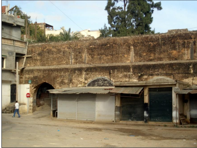
Fig. 8. Pont-aqueduc de Tixeraine, dernier ouvrage d'art de l'aqueduc de Birkhadem encore debout (cliché auteure, 2011).
