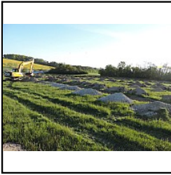
Vue d'ensemble de la parcelle diagnostiquée
