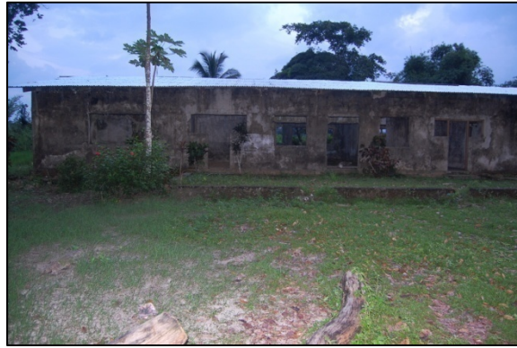
Photo 18. Bâtiment de la paroisse catholique récemment « retôlé » (2010)
