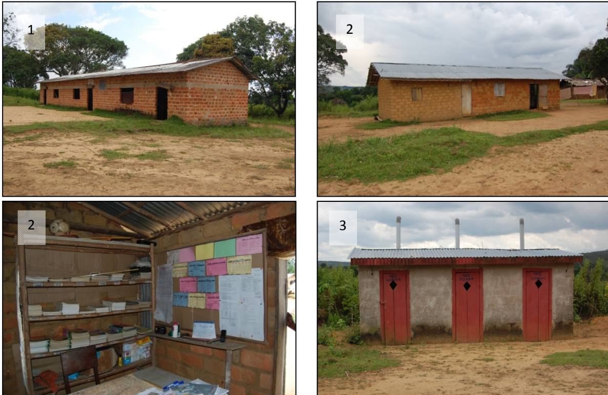
Photo 66. Les bâtiments de l'école primaire de Mambio
