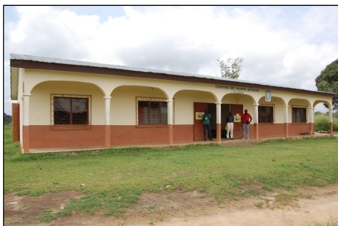
Photo 45. Le CSI nouvellement construit de Vinza-centre
