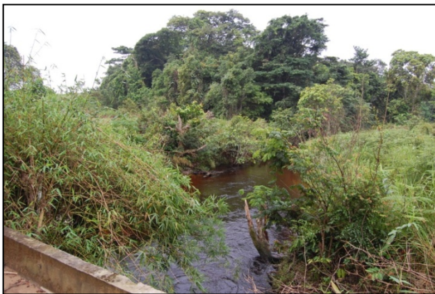
Photo 3. Type de rivière et de pont présents dans le district de Vinza
