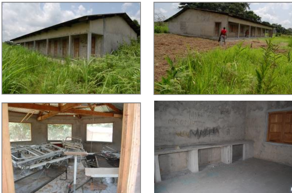
Photo 53. Une structure de santé de Mounoko au statut indéfini est actuellement en construction
