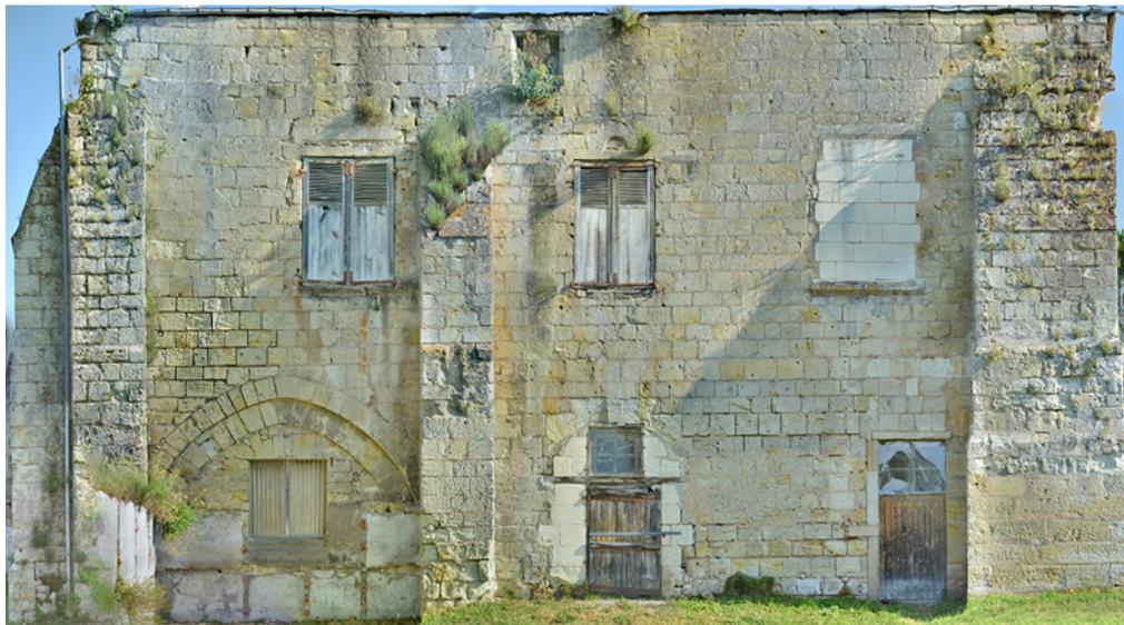
34 Plusieurs contreforts rythmaient les façades, mais leur largeur n'est pas constante, s'adaptant peut-être aux poussées exercées par la structure interne. Des contreforts ont été ajoutés au bâtiment 5, pour renforcer les maçonneries à l'emplacement des supports de la voûte nouvellement créée.
