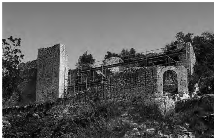
Fig. 198 – BUOUX, Fort. Le secteur du corps de garde en cours de restauration, partie extérieure (cliché Chr. Markiewicz).
