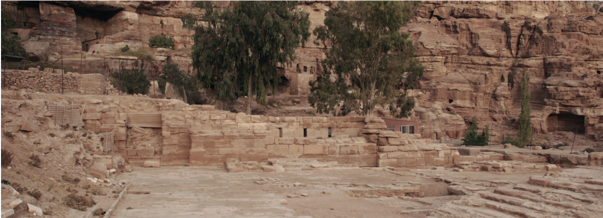
Fig. 7.3. Le monument impérial à abside : vue générale de la face est.
