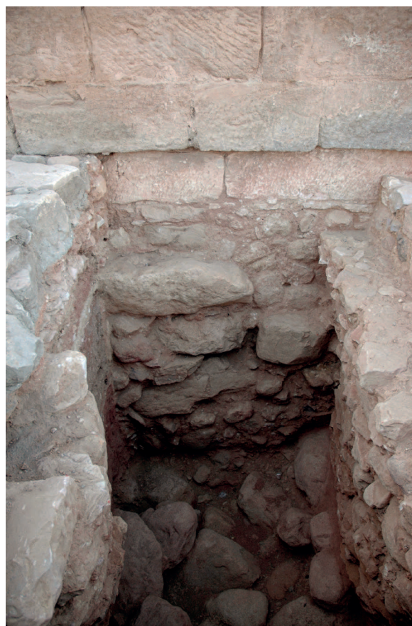
Fig. 7.8. Le monument impérial à abside : sondage sur les fondations au pied de la partie centrale de la face est.
