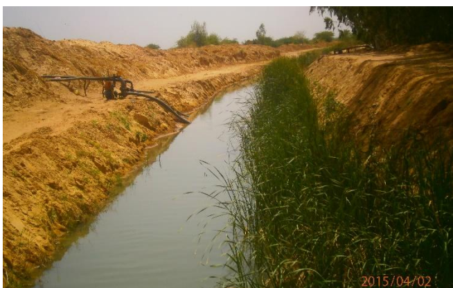
Photo 4 : Pour irriguer les terres du jeeri, des canaux à ciel ouvert sont réalisés. A partir de ces canaux, des groupes motopompes envoient l'eau vers les périmètres.
