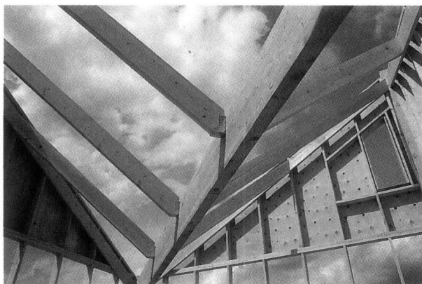
Les nouvelles règles d'utilisation des bois dans la construction vont permettre de mieux utiliser les bois français en structure.
