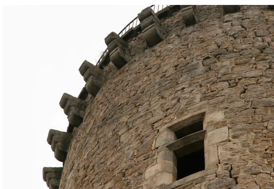
Fig. 27. Couronnement de la tour.
