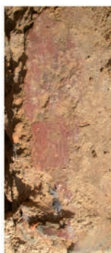
Fig. 4 – Caractéristiques architecturales de l'aqueduc de Montjeu : 1 , détail du mortier de tuileau, vue du conduit dégagé en 2006 (cliché : L. Borau, TRACES) ; 2 , couches de mortier de tuileau du canal, a , couche supérieure riche en chaux, b , mortier aérien avec inclusion de TCA, c , mortier hydraulique, d , béton hydraulique (cliché : L. Borau, TRACES) ; 3 , détail de la couche de finition (cliché : F. Rivière, TRACES ; DAO : L. Borau, TRACES) ; 4 , coupe de l'aqueduc à Couhard (Roidot-Deléage, pl. 72).
