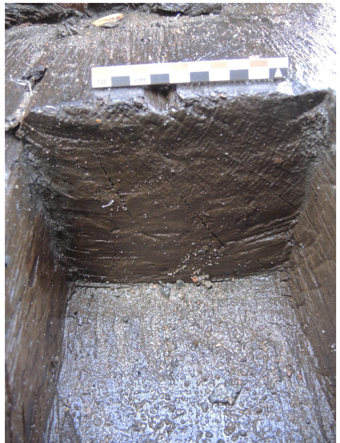
Fig. 15 : Rezé, Saint-Lupien. Mortaise de la sablière SA40715 (cliché : F. Épaud 2014).
