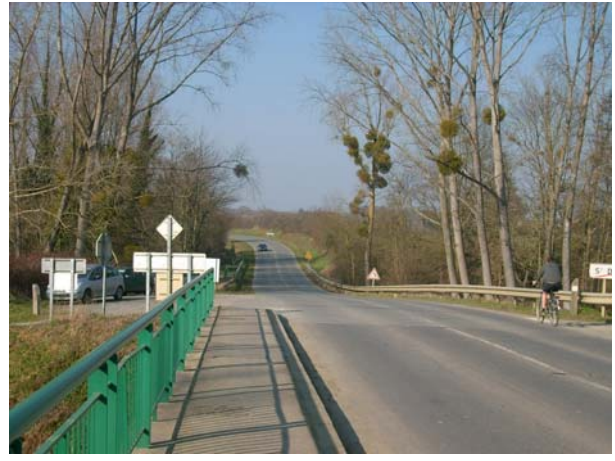
Jonction route/canal à St-Domineuc : vue vers Pleugueuneuc
