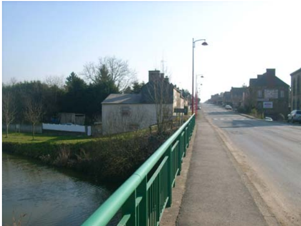
Jonction route/canal à St-Domineuc : vue vers le bourg de St-Domineuc
