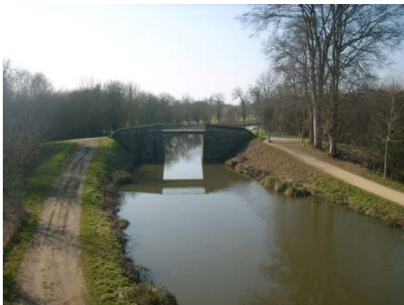
Au pied de la voie rapide, vers Trévérien, un pont piétonnier. Passage confidentiel compte tenu de ses accès
