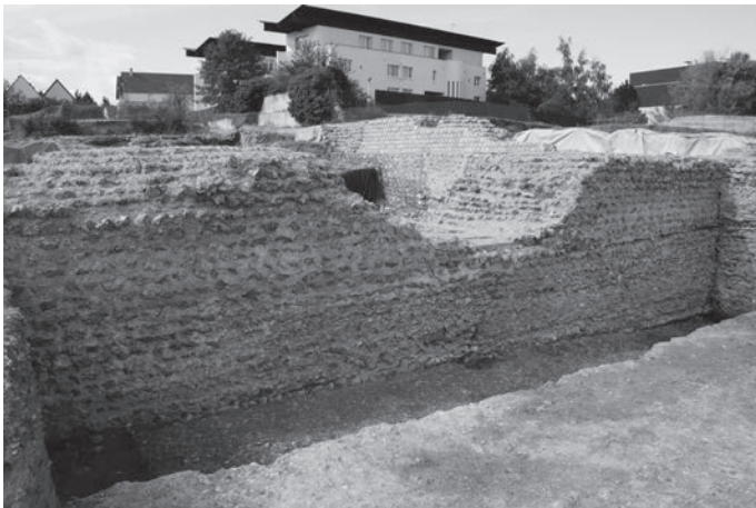
Fig. 7 – Parement est du soubassement du péribole oriental : les différentes étapes de construction. Sous la récupération de l'égout (au centre du cliché), trace du chaînage en biseau (cliché : B. Bazin, SAVC).
