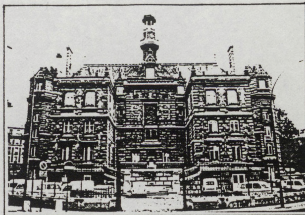
Façade arrière de la Mairie
