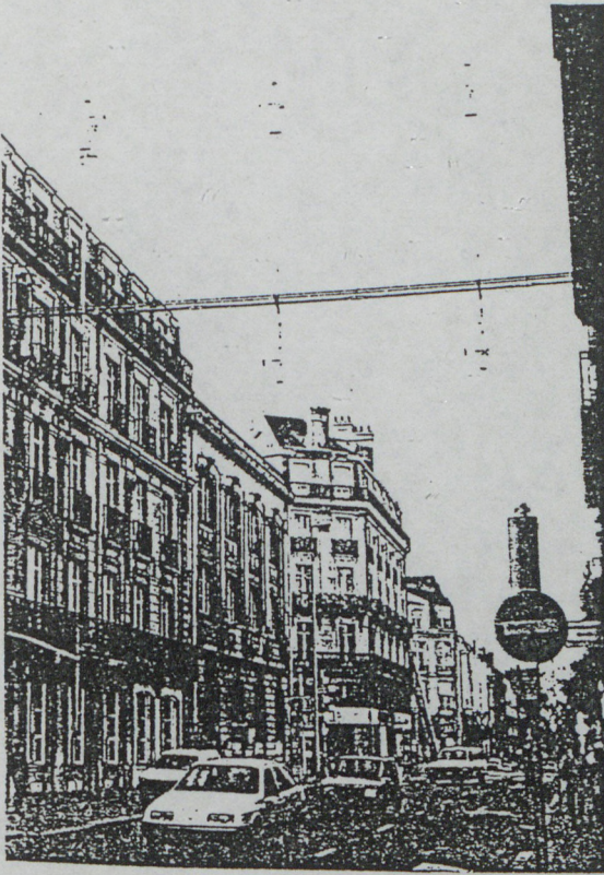
Figure 3 : partique de mesures
