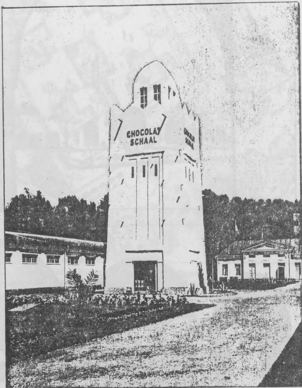
F25 Pavillon du chocolat Schaal (1924), BMS Dopff, architecte
