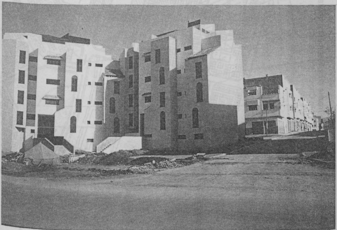
PL.7 Le lotissement d'Aïn Chock au Sud de Casablanca : en haut, les premières maisons d'habitat économique en construction (1984); en bas, les immeubles d'habitat collectif faisant écran aux maisons (1989).
