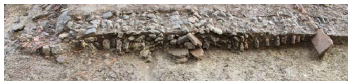
Fig. 78 – Le mur-pignon du portique sud effondré, vu en coupe du nord-ouest (cliché : A. Lanteri, Inrap).
