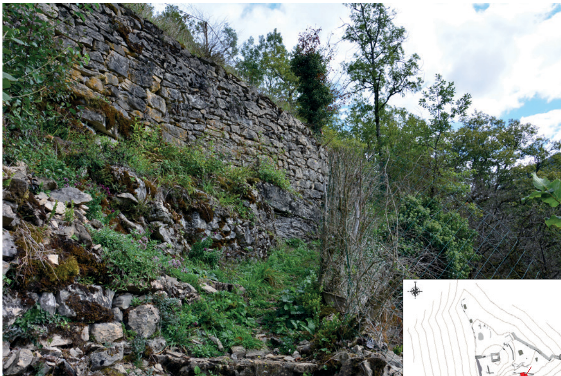
2. Mur de terrasse (ancienne courtine ?) sous la grotte.
