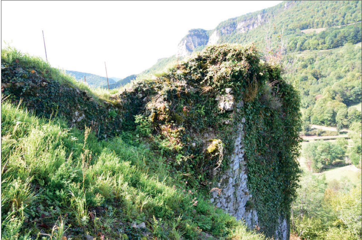
1. Angle nord-ouest de la cour haute et chemisage du mur nord.
