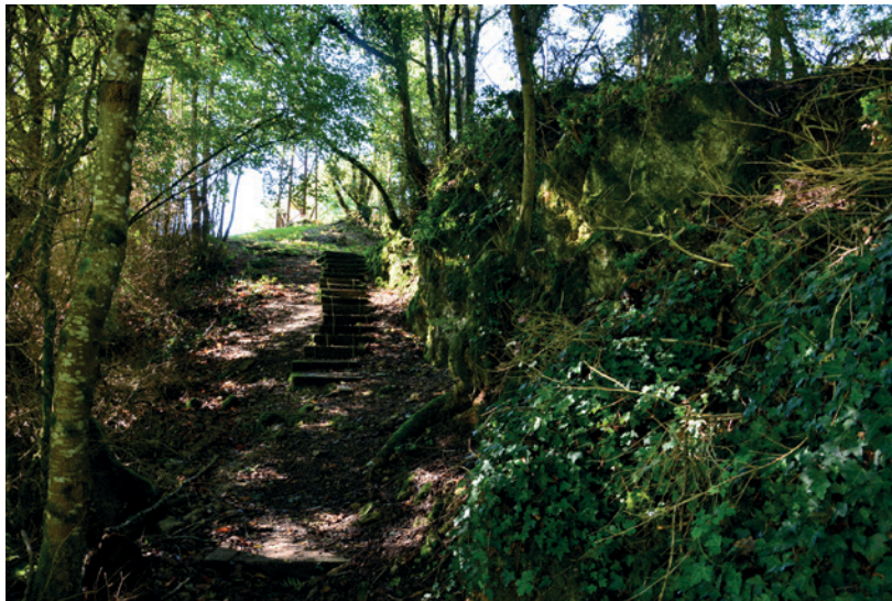
1. Escalier d'accès nord.
