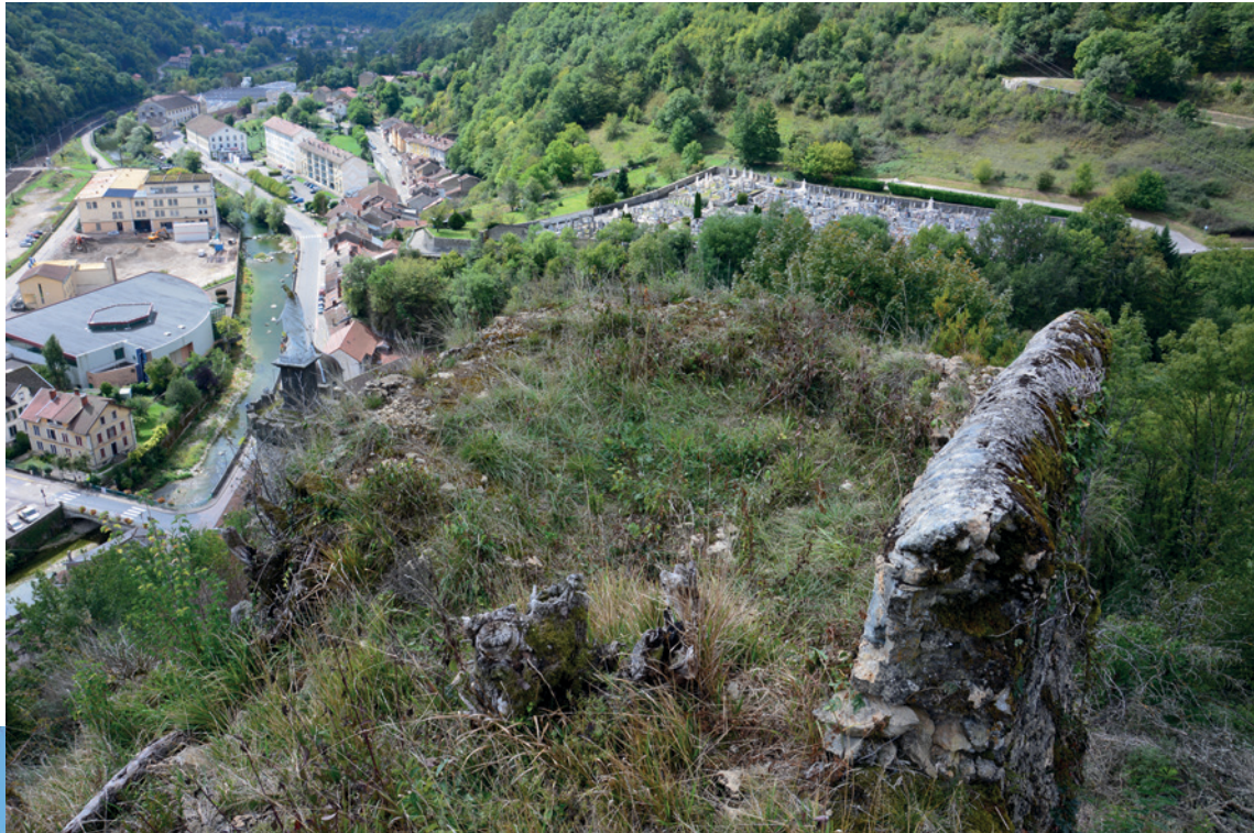
1. Arase de la tour ronde située au milieu de la courtine sud-ouest.
