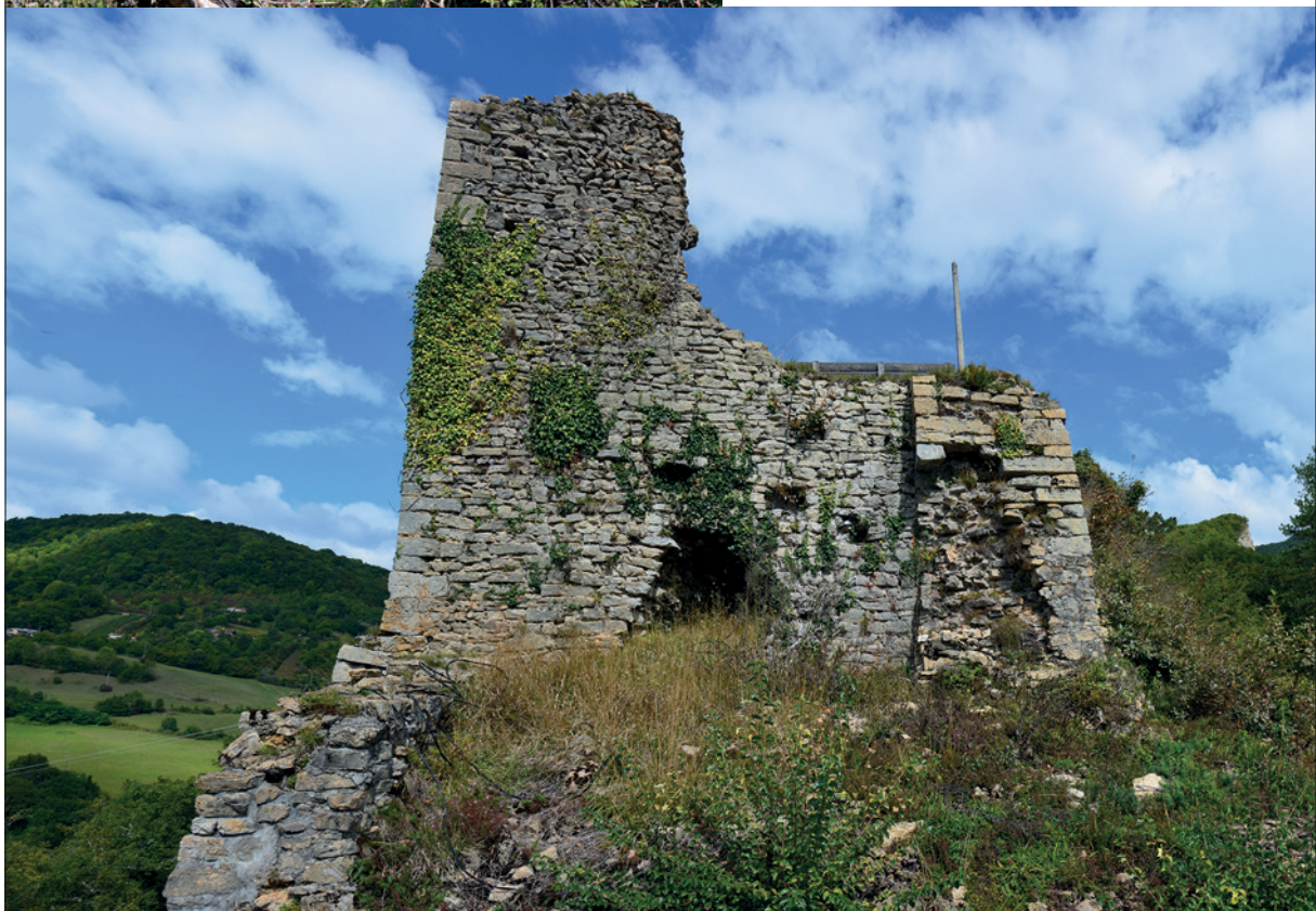
Fig. 15 : Les contreforts d'angles de la cour haute. Clichés : L. D'Agostino.
