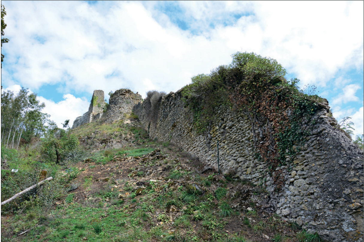
1. Courtine sud-ouest vue du sud-ouest.
