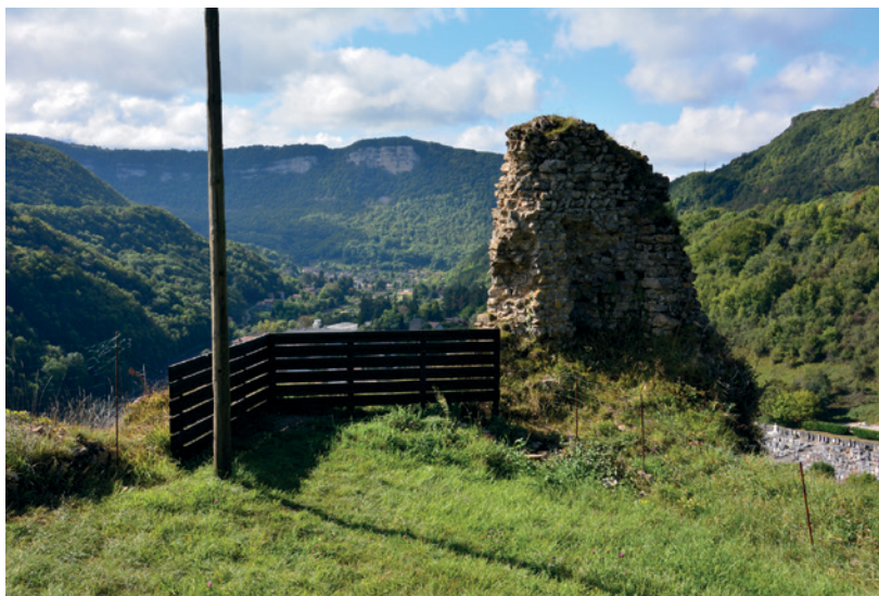
2. Barrières de protection de la cour haute : rembarde bois et grillage.
