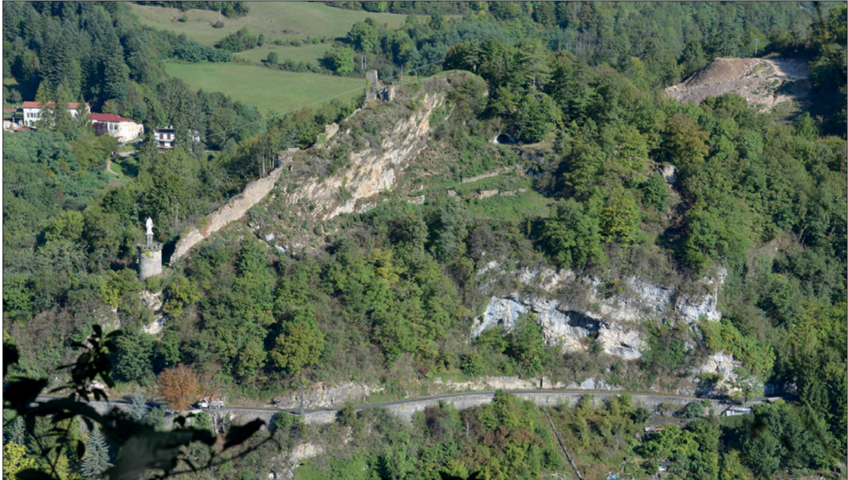
1. Léperon portant le château de Cornillon vu du sud.
