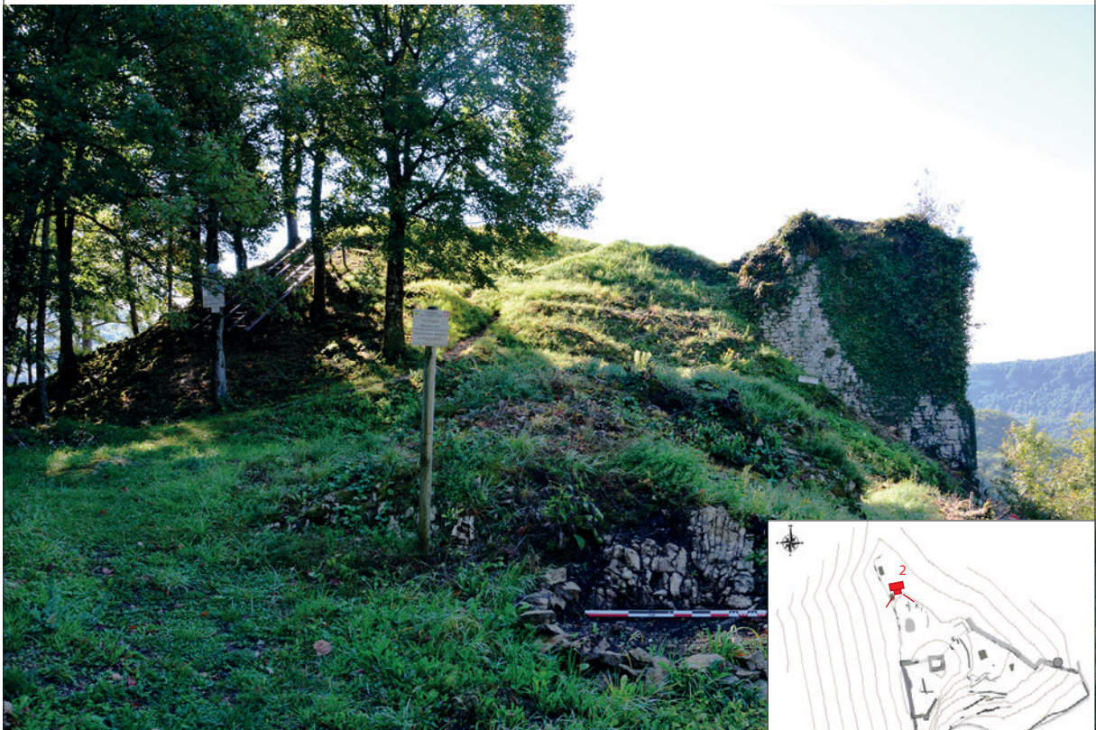
2. La cour haute vue du nord. Le cône d'éboulis de la tour est à gauche de l'image.
