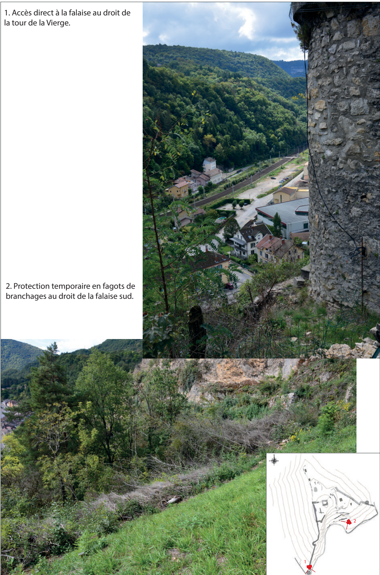
Fig. 28 : Accès à la falaise sous la tour de la Vierge et protection en fagots de branchages. Clichés : L. D'Agostino.
