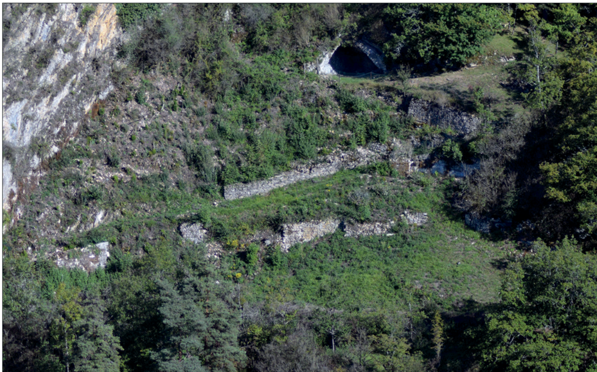
1. Ensemble de murs de terrasses au sud-est du site, sous la grotte.
