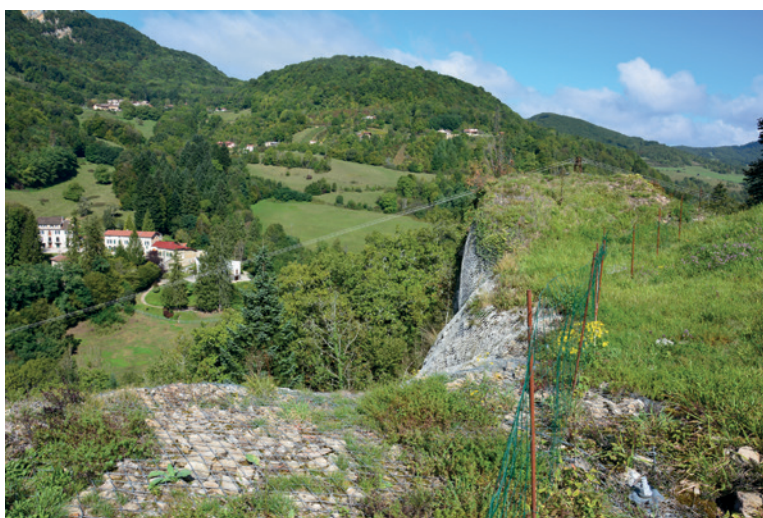
3. Barrières de protection de la cour haute à l'ouest et confortement de la courtine ouest (filet pare-gravois et béton projeté).
