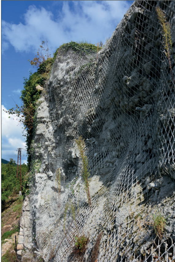
1. Pare-gravois au niveau du parement extérieur de la courtine ouest de la cour haute.
