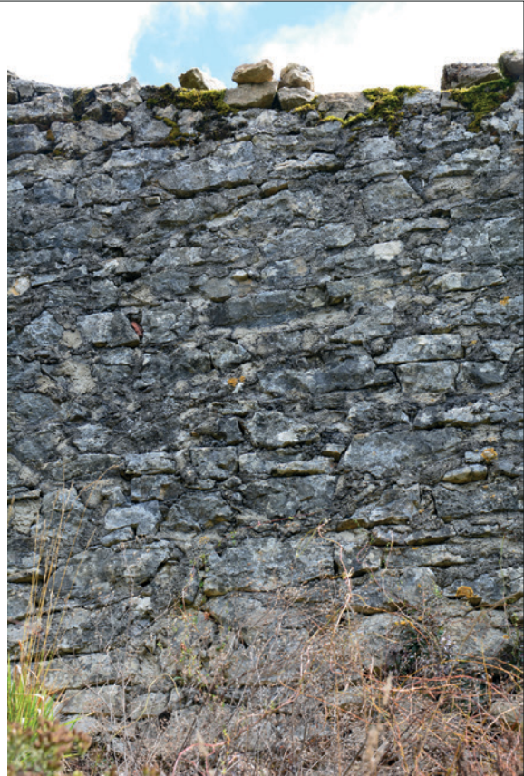
2. Restauration ancienne de la courtine sud-ouest.
