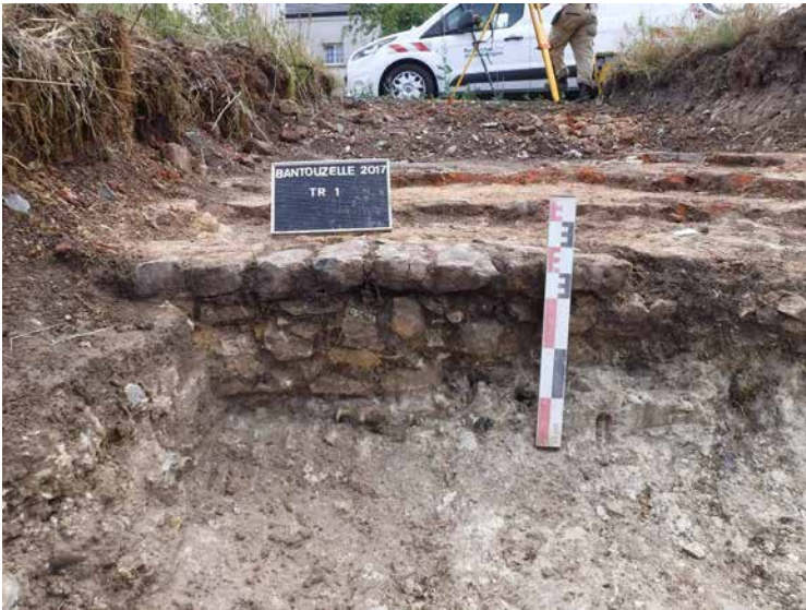
Fig.15 : détail de la fondation 1007 parallèle à la rue du château. Secteur de l'aile nord. © Evelyne Gillet - Inrap.
