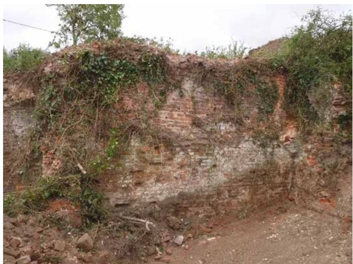
Fig.23 : vue du parement externe en élévation de la cave 1. © Evelyne Gillet - Inrap.
