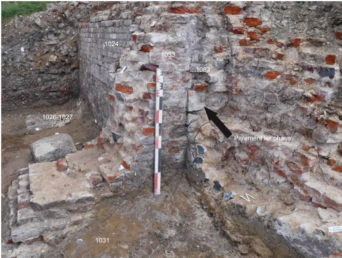
Fig.26 : détail des premier et second parements du mur goutereau et du contrefort. © Evelyne Gillet - Inrap.
