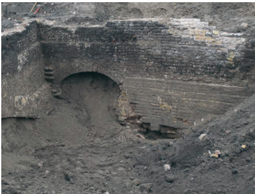
Fig. 106 : Sd. 16 - Vue de l'arche incluse dans le mur de berge occidentale du Canal de Furnes Cliché : © Thierry Marcy - Inrap
