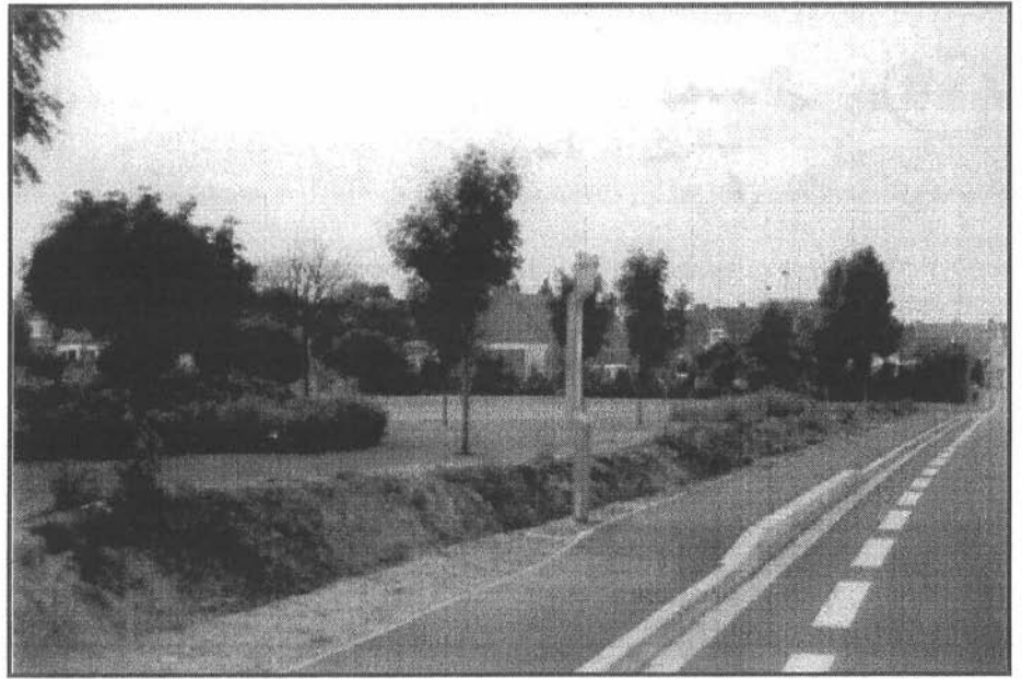
Arrêt Godion (ligne 81) Bande cyclable et trottoir étroit
