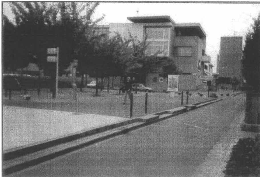
Arrêt Esplanade (Douai) (ligne 8 et 81) Aménagement d'accessibilité avec emmarchement
