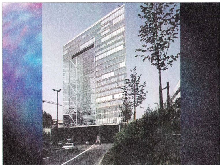
Accès sud sous l'immeuble-tour en verre construit (après l'ouverture du tunnel) au-dessus de l'accès sud, non-prévu au départ, dont les fondations ont pu être intégrées dans la construction du tunnel
