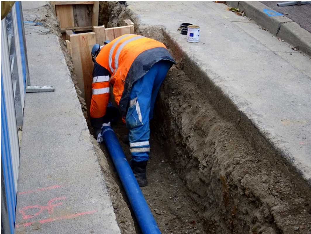
Figure 22 Emboîtement de deux tuyaux en fonte, chantier en région parisienne (photo équipe GESPARE 2019)
