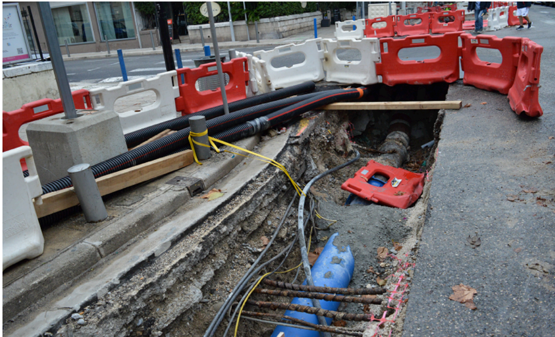
Figure 19 La délicate gestion de l'enchevêtrement des réseaux souterrains: enjeux de coordination, lendemains d'orage et découvertes imprévues de câbles posés sur les canalisations (équipe GESPARÉ 2018)
