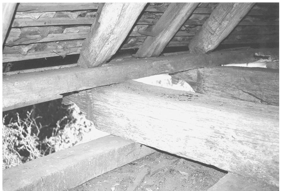
Fig. 17 - Vue intérieure des sculptures des abouts d'entrants.
