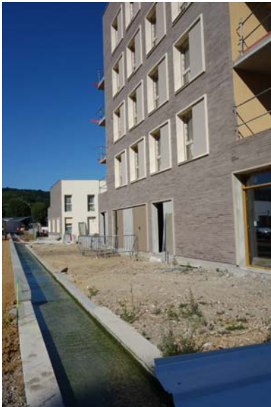
Figure n°11. Le la Luciline au cœur des chantiers (photographie auteur W Hucy, 2016)
