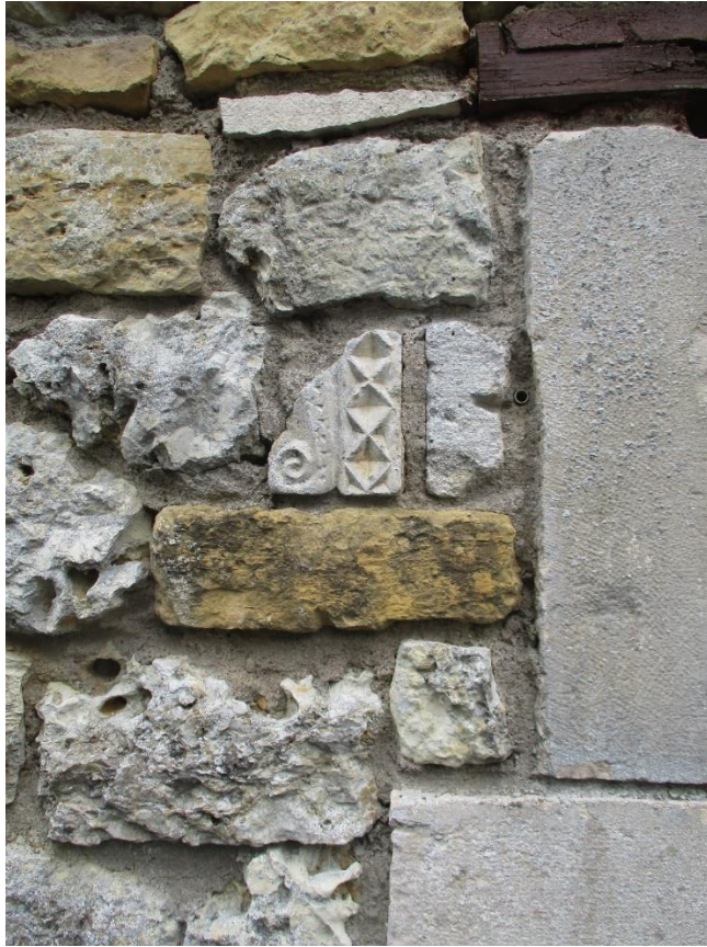
m. Grange attenante, mur ouest (remploi d'un élément ancien)
