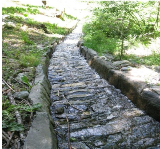
Figure 24 : Canal de l’Arc à Montrigon, section nouvellement empierrée, Bourg-Saint-Maurice, 27/6/12 (cliché B. Meilleur)
