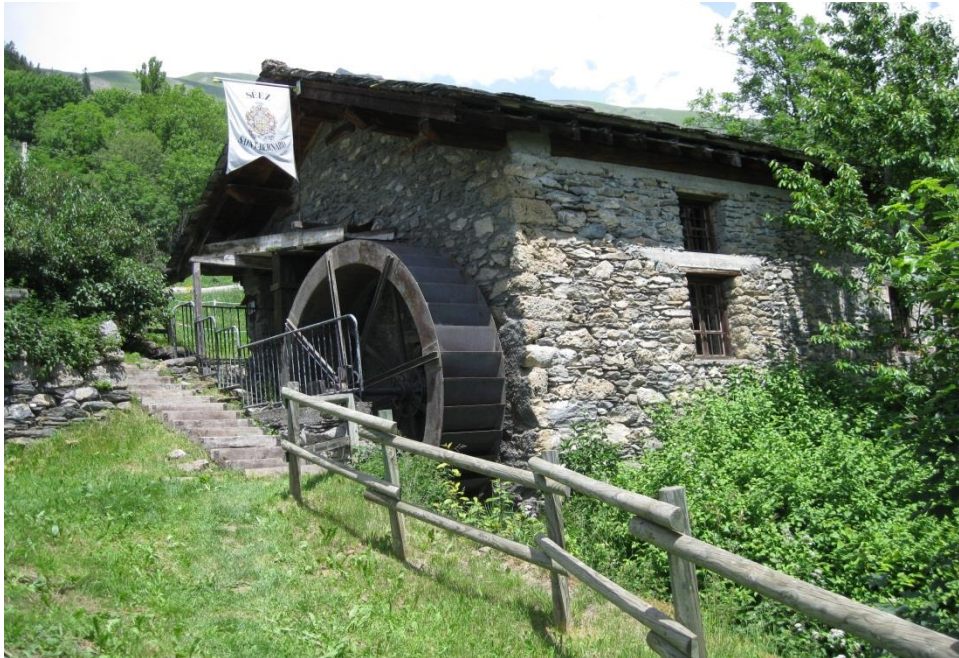
Figure 2: Moulin de Saint-Germain (moulin à blé, restauré), Séez, 21/6/12 (cliché B. Meilleur)
