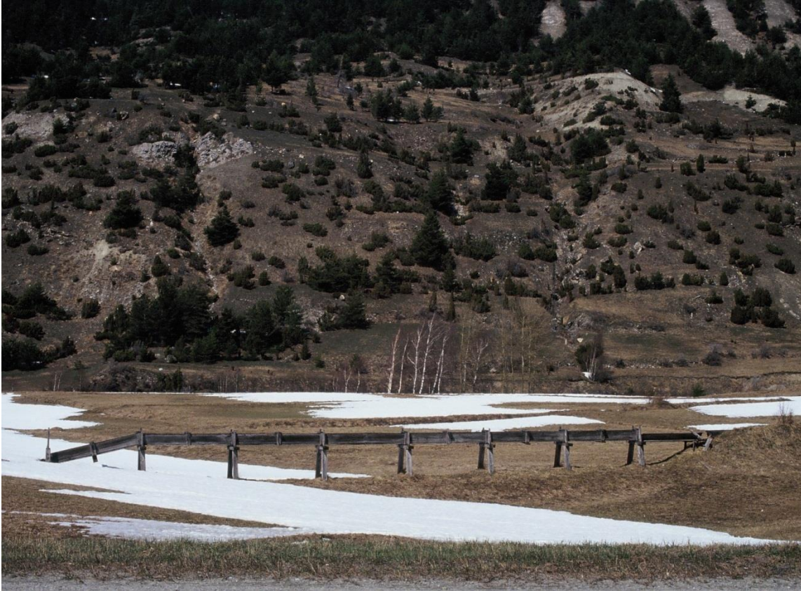
Figure 13 : Canal du Verney, aqueduc en bois, Bramans, 5/5/80 (cliché B. Meilleur)
