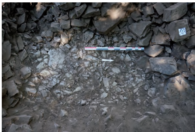
Figure 67 - Blocs disposés en boutisses parpaigues
