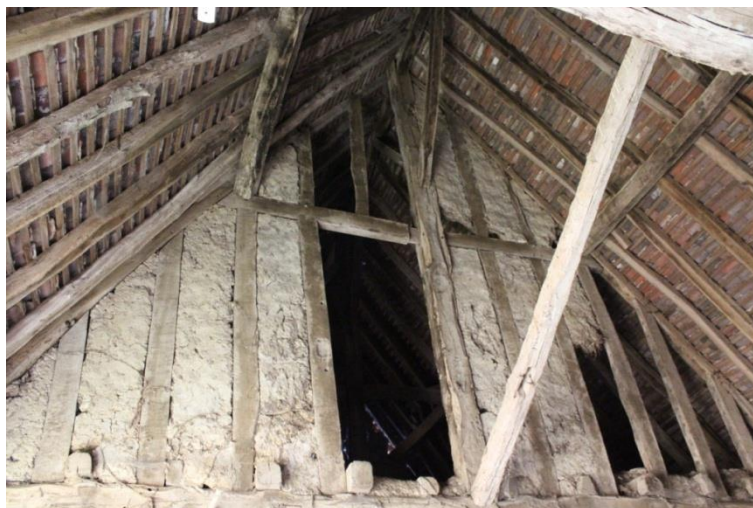
Figure 59 : Charpente du bâtiment à la Haloperie (Fontaine-les-Coteaux)
