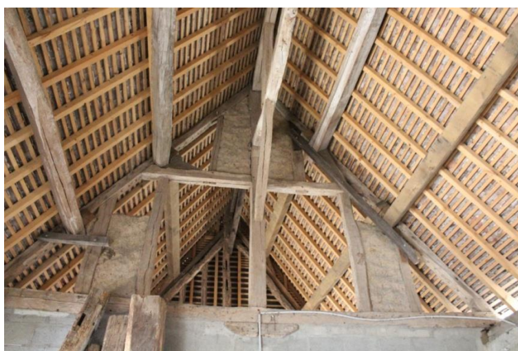
Figure 58 : Charpente de la grange de la Fosse de Ranay (Saint-Martin-des-Bois)
