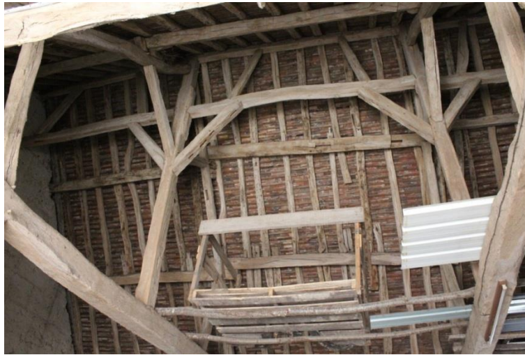
Figure 62 : Charpente de la grange au Petit Villemalour (Saint-Martin-des-Bois)
