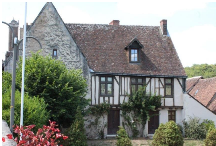
Figure 78 : Maison au 2, rue Saint-Oustrille, côté cour
