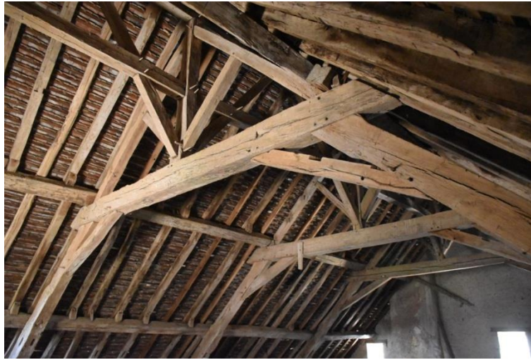
Figure 68 : Charpente de la mairie de Sougé construite en remployant les bois de la charpente du XV e siècle.
