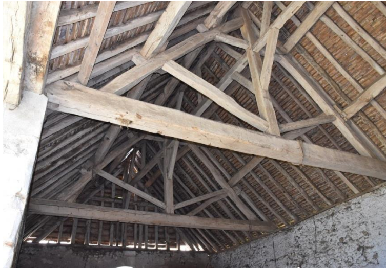
Figure 64 : Charpente de la grange du Prieuré de Courtozé (Azé)
