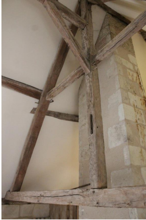
Figure 60 : Ferme de la charpente du 8, rue Marescot (cloître des Augustins) à Montoire
