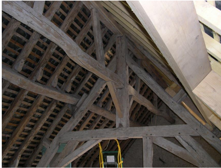
Figure 66 : Charpente du bâtiment au 25, rue Haute (Trôo) (photographie M. et Mme Ourceau)
