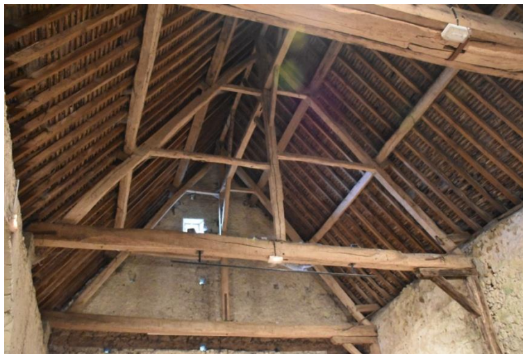
Figure 61 : Charpente de la grange du château de la Possonnière (Couture-sur-Loir)
