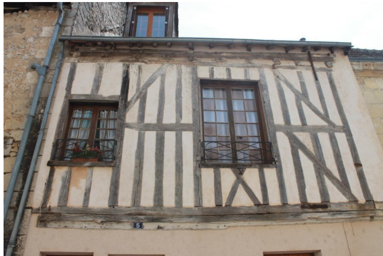
Figure 82 : 5, rue du Boël à Montoire
