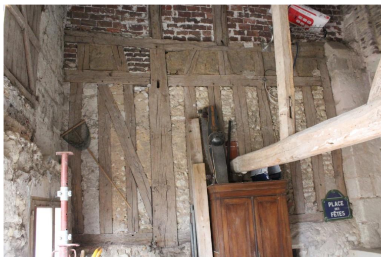
Figure 85 : Pan de bois nord de la fosse de Ranay (Saint-Martin-des-Bois)
