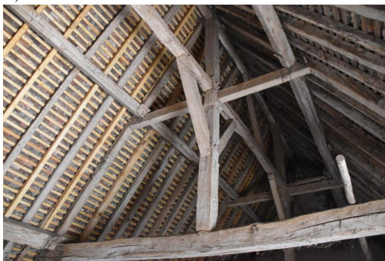
Figure 57 : Charpente du logis principal au Grand-Gué (Saint-Martin-des-Bois)
