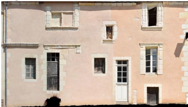
Figure 15 : Façade sud du 31 rue de la Mairie (Sougé)
