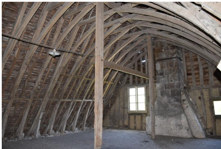
Figure 69 : Charpente du logis du prieuré Saint-Gilles (Montoire)
