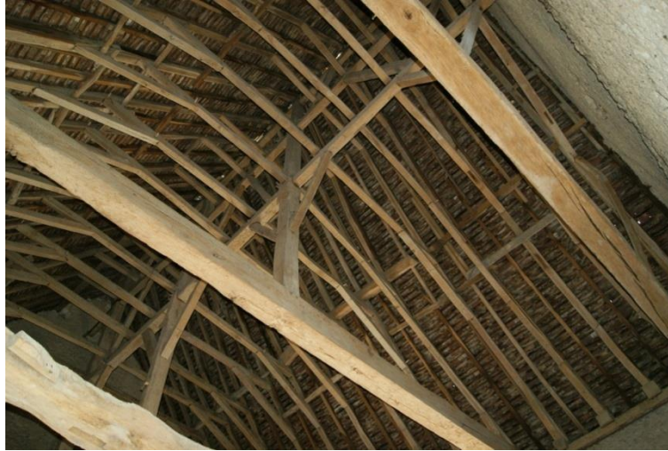
Figure 73 : Charpente de la grange au 11, rue Pied-de-Mai (Lavardin)
