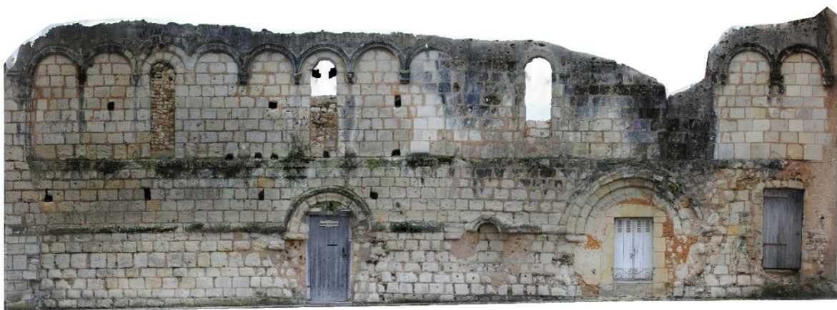
Figure 16 : Façade nord de la "maladrerie" de Trôo
