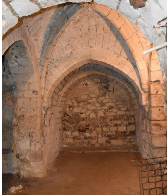
Figure 47 : la cave de l'aitre Billebarbe, bouchage formant le fond de la niche nord
