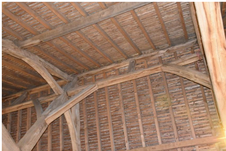
Figure 56 : Aperçu du niveau de sous-faîtage de la grange de la Couture (Montoire)
