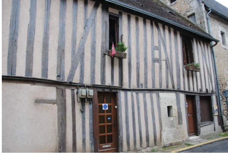
Figure 75 : Maison au 1, rue du Boël à Montoire
