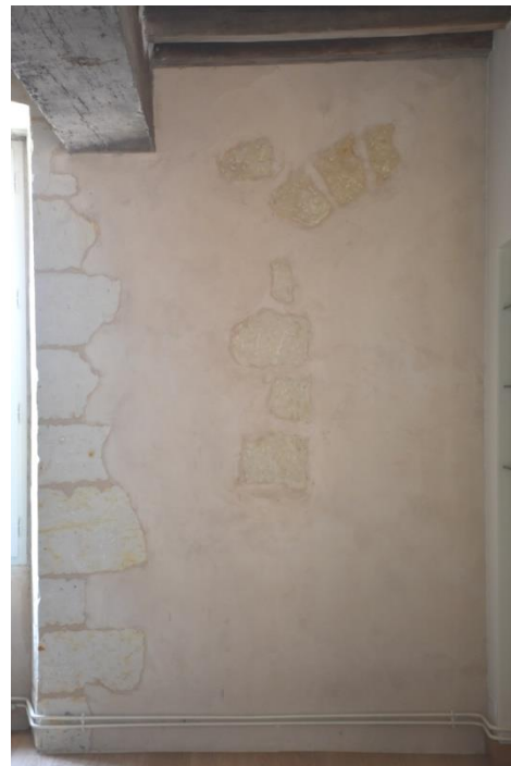
Figure 42 : Ouverture couverte d'un arc surbaissé à l'angle SO de l'étage dans le mur sud de la mairie de Sougé
