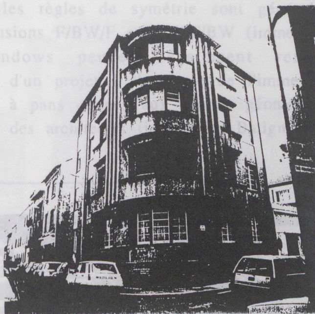
Fig.(57): Immeuble Bertoluzzi, arch.: Munvez, 1938
