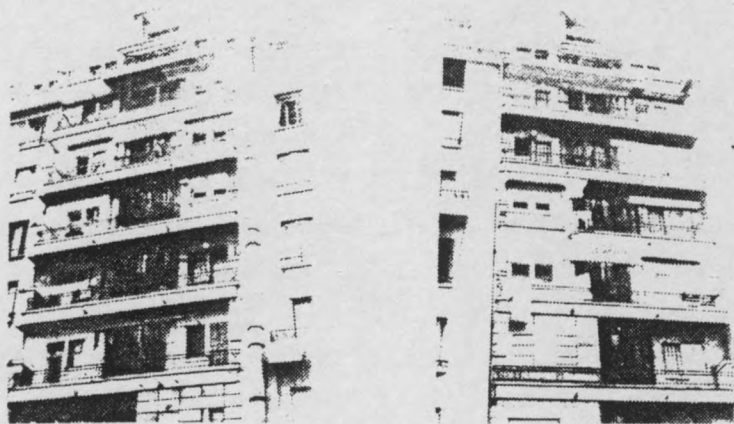
44-46, rue Thiers, 1934, Benoît & Bonnat architectes. "Les monte-charges sont des éléments de composition de la façade sur cour".
