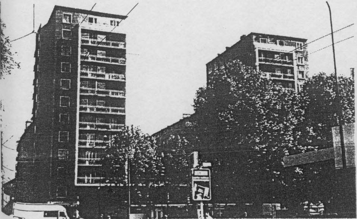
Pl. 2. Résidence "Vallier" situé au 2-4, rue P. Ruibert; 91-93, rue de l'Abbé Grégoire; 22-24-26, boulevard Joseph Vallier.
