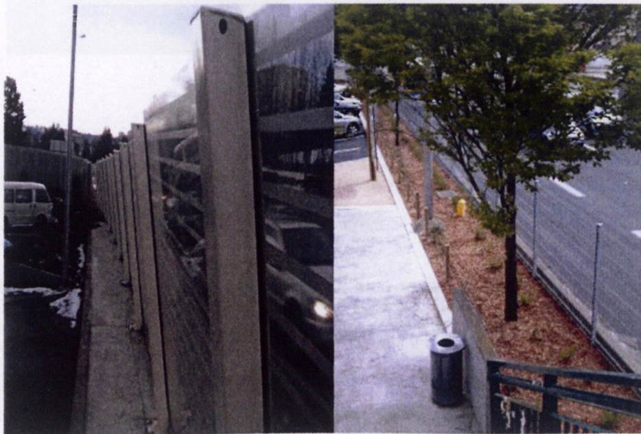
Mur antibruit et barrière végétale aux abords de la RN88
