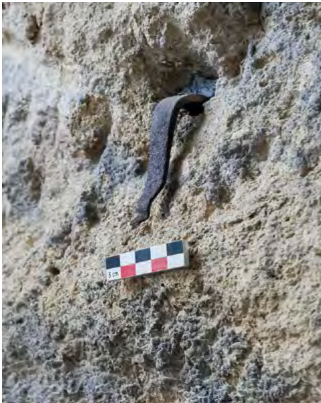
Fig. 170 – ORANGE, PCR « Architecture, technique et décor du théâtre antique ». Une patte à marbre et sa cale en plomb dans une cavité du front de scène (cliché S. Dubourg/IRAA).
