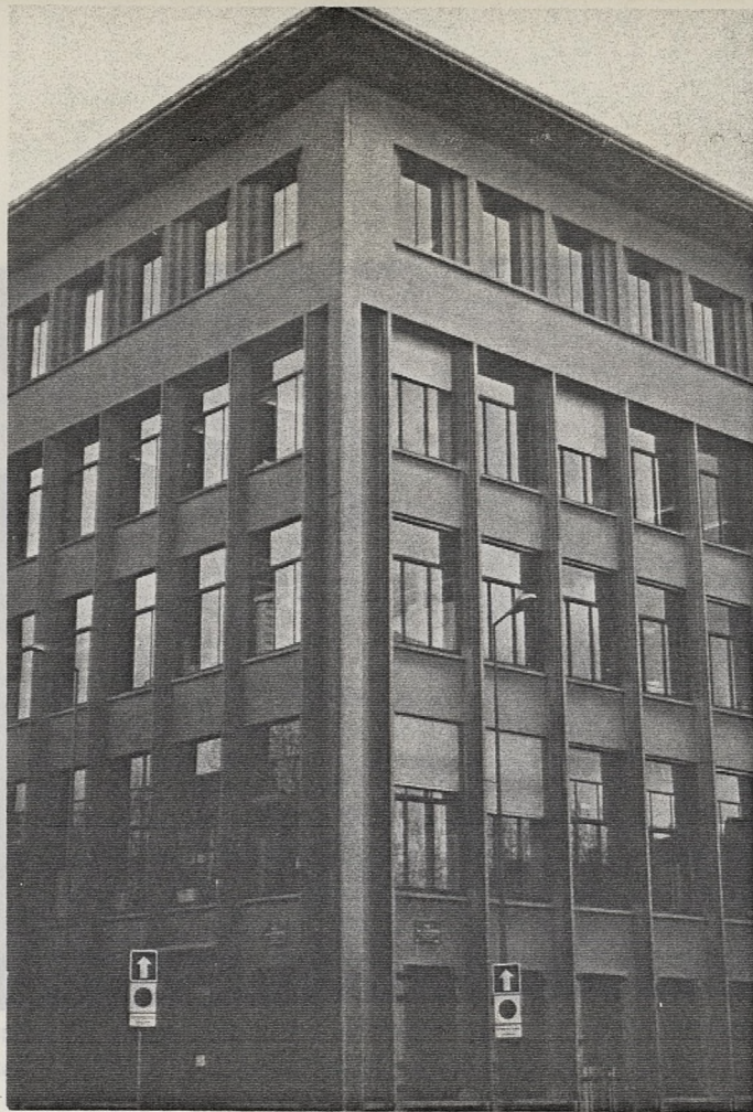
Mairie de BOULOGNE-BILLANCOURT - Façade arrière Etat actuel (photo 1982)
