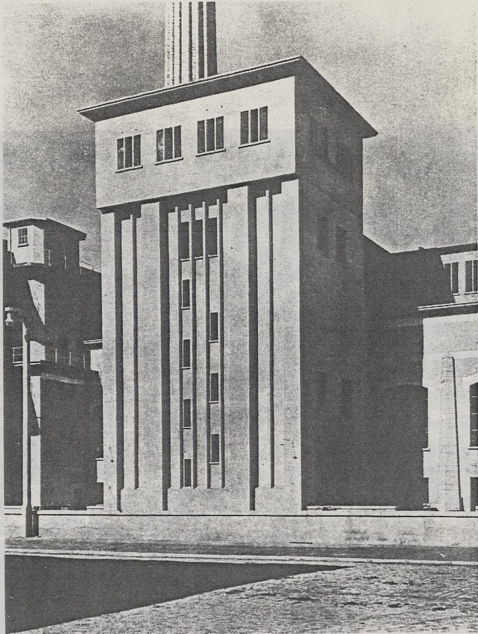
VUE GÉNÉRALE DE LA VILLE DE LYON. — BÂTIMENT DES MACHINES. FIG. 6. — ABATTOIRS DE LA VILLE DE LYON. — Bâtiment des machines.
