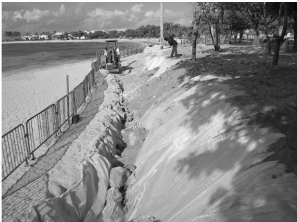
Fig. 3 – Pose du dispositif de protection provisoire au cimetière des Raisins-Clairs à Saint-François en Guadeloupe. Un géotextile emballe la microfalaise (© C. Stouvenot).
