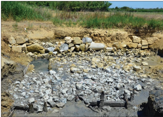
Fig. 18 – À Mandirac, contre la digue qui est surélevée par l'accumulation de fragments d'éléments d'architecture monumentale (en arrière-plan), un caisson rempli de blocs (premier plan) sert à la renforcer du côté de la lagune (cliché : C. Sanchez).
