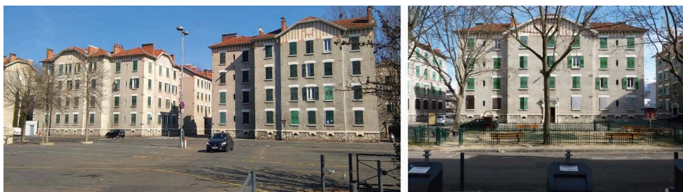
Travail de groupe dans le cadre de l'étude sur le renouvellement urbain du quartier de l'Abbaye. Ryma Hadbi et Particules/Bazar Urbain. Licence CC-BY-NC.
