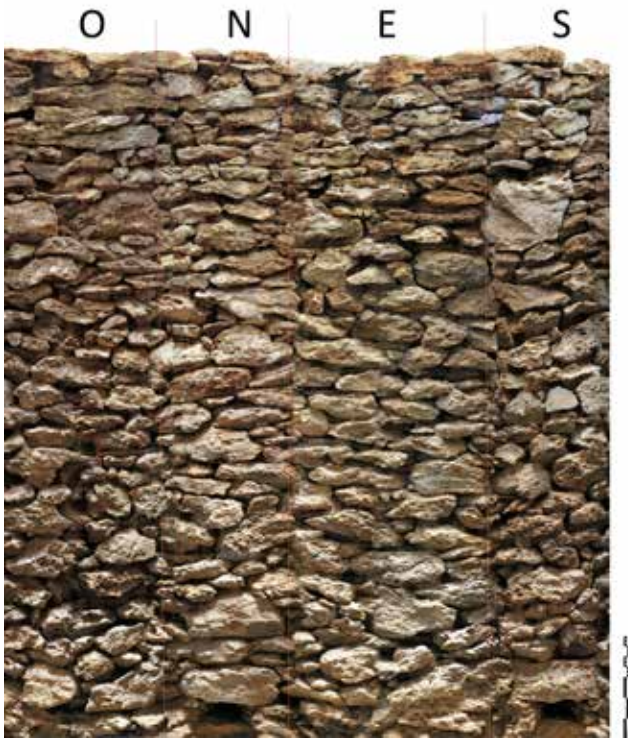
Fig. 05 Chessy (Seine-et-Marne), « ZAC des Studios et Congrès ». Déroulé des quatre faces de la cheminée d'accès jusqu'au niveau de l'eau. © Pyxeos.
