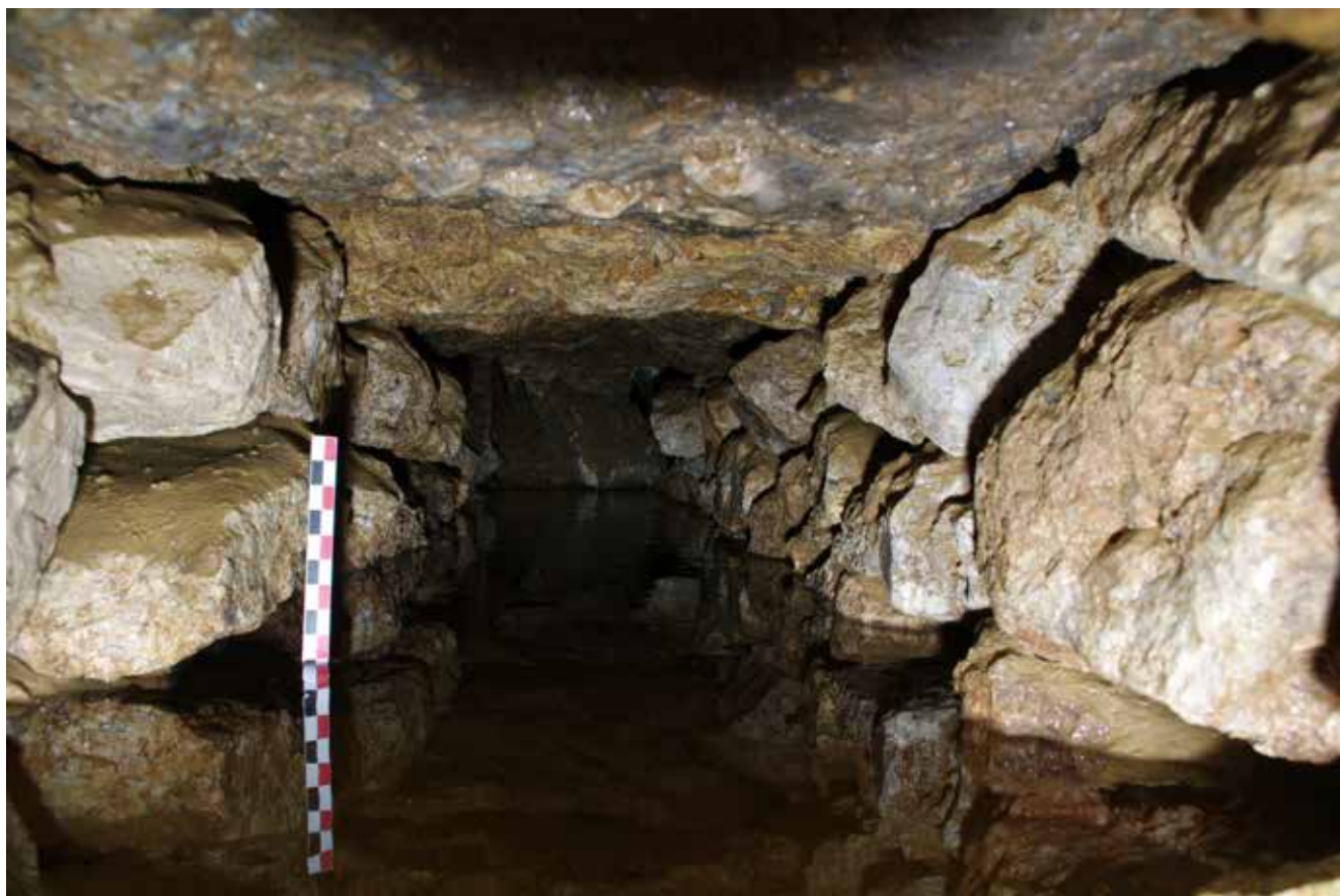
Fig. 03 Chessy (Seine-et-Marne), « ZAC des Studios et Congrès ». Intérieur de la canalisation au niveau du sondage profond. © Paléotime.
