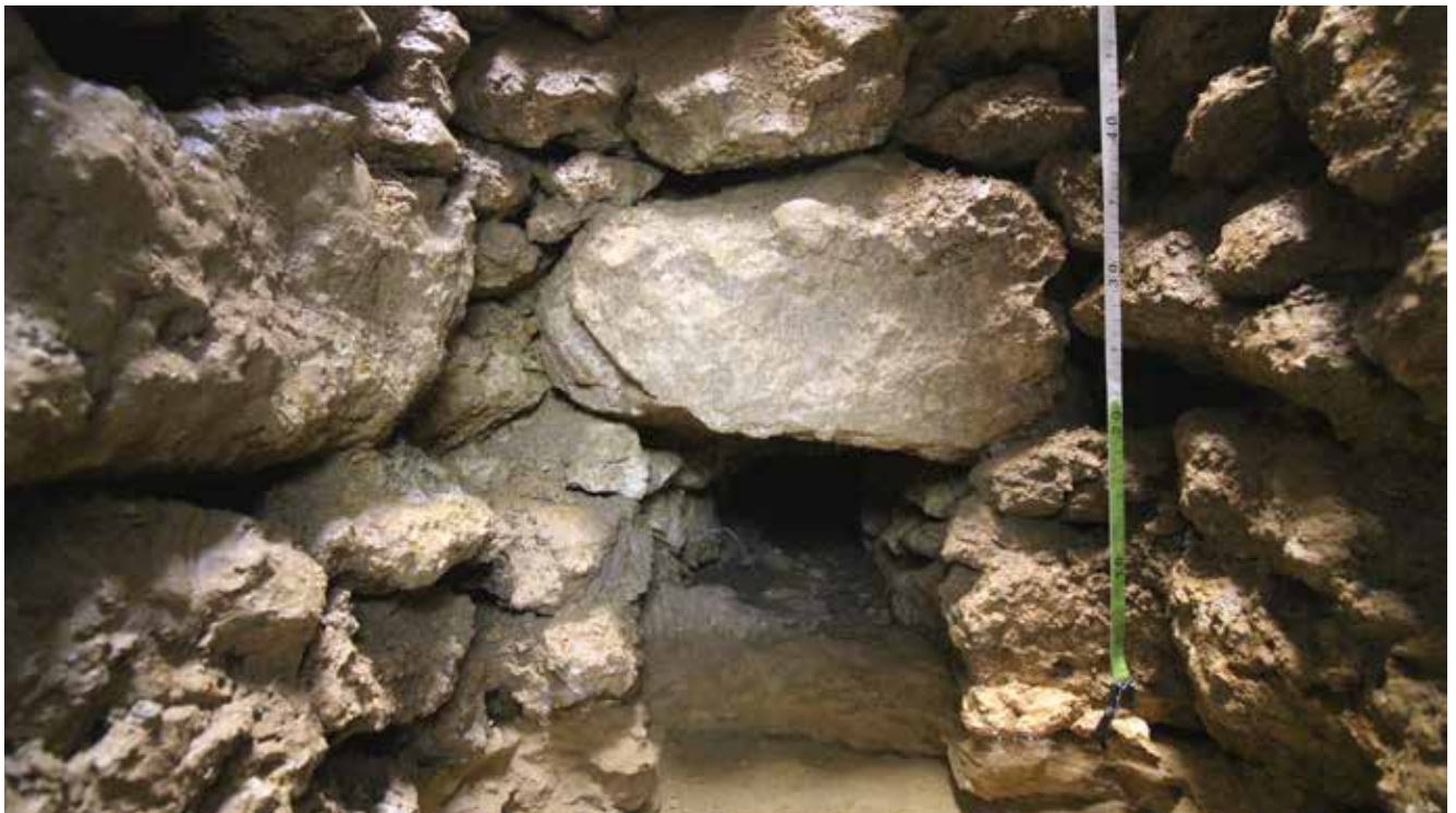
Fig. 06 Chessy (Seine-et-Marne), « ZAC des Studios et Congrès ». Base de la cheminée d'accès et ouverture de la canalisation. Au travers de l'eau on distingue la sole du conduit plus élevée que le fond de la cheminée. © Pyxeos.
