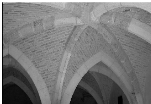
Fig. 16. Détail des ogives de l'ancien cellier. On distingue les voussoirs d'origine, plus sombres.
