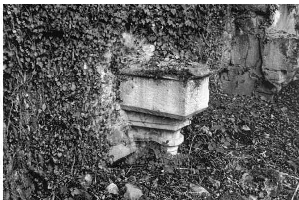
Fig. 6 et 6 bis. Jambage et corbeaux des cheminées des salles hautes et basse.
