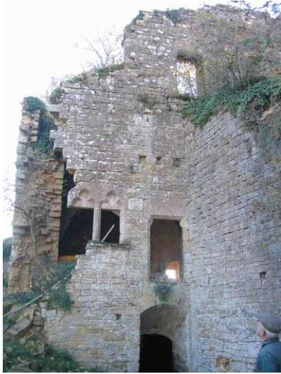
Fig. 3. Tour sud-est, façade ouest sur cour
