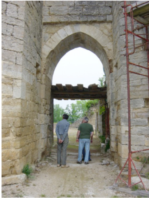
Fig. 2. Vue générale de la porte
