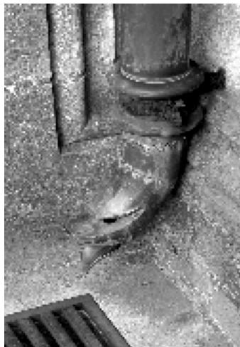
Fig. 27. Détail du débouché d'une gouttière du corps de logis
