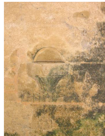
Fig. 8. Orifice du réservoir au-dessus de l'évier
