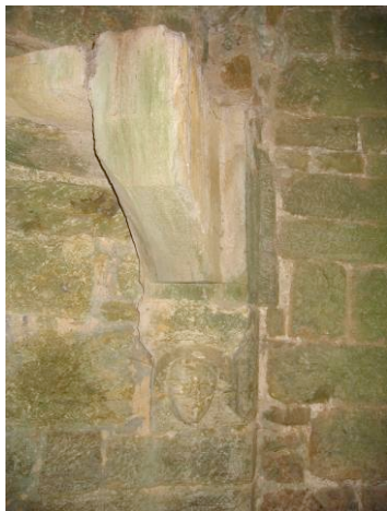
Fig. 15. Piédroit droit de la cheminée
