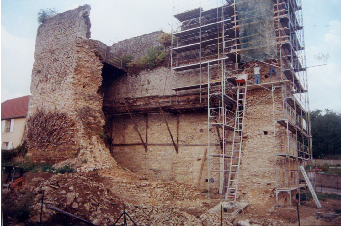
Fig. 1. Vue générale depuis le sud-est, les murs apparaissent en écorché, avec leur blocage interne. Le mur est (à droite) est en cours de consolidation, alors que le mur sud n'a subi aucune intervention. On peut observer les trous correspondant à un double chaînage interne par poutre. Les deux niveaux sont visibles dans le mur oriental, mais seul le niveau supérieur se distingue dans le mur sud. (cliché E. Laborier, Afan, 1999)
