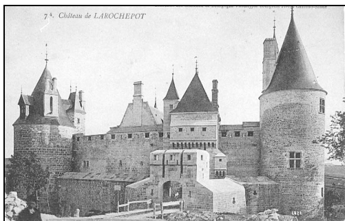
Fig. 15. Vue nord du château, avec sa barbacane au premier plan
