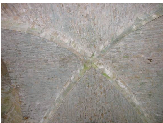
Fig. 13. Voûte sur croisée d'ogives surplombant le premier niveau
