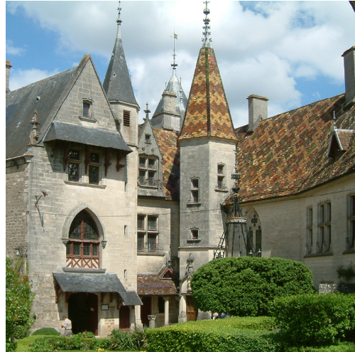
Fig 4. Vue de l'angle nord-est de la cour, après restauration
