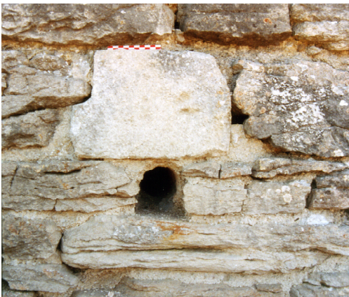
Fig. 10. Vue de détail du parement extérieur du mur nord. Il s'agit d'un bloc de calcaire blanc coquillé réemployé, avec comme face visible en parement, un lit de pose. On notera le trou de boulin circulaire et la moindre qualité des autres pierres mises en œuvre. (Cl. E. Laborier, Afan, 1999)
