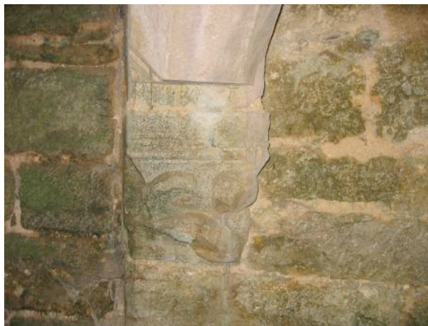
Fig. 16. Piédroit gauche de la cheminée
