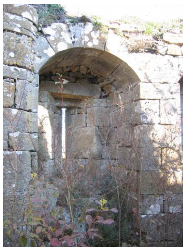
Fig. 18. Étage de tir ; archère sous niche.
