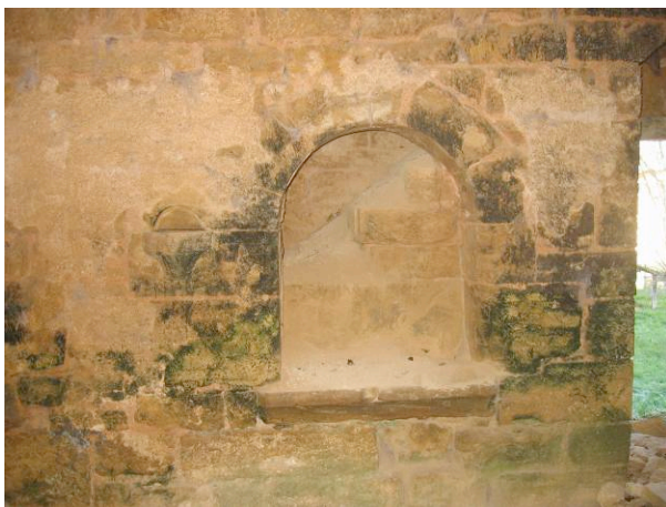
Fig. 7. Évier de la façade ouest
