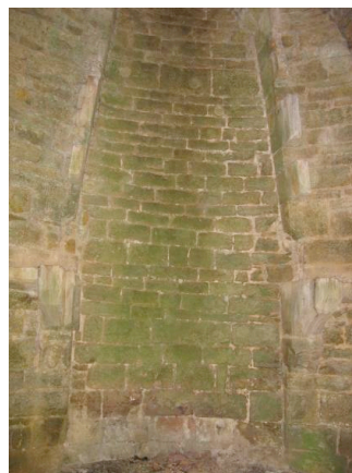
Fig. 14. Cheminée du premier niveau
