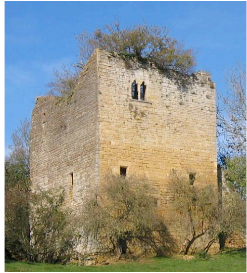
Fig. 4. Tour sud-est ; façade est
