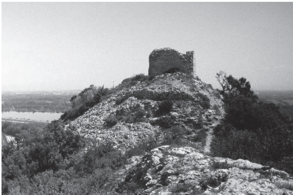
Fig. 6 : tour de la Caramude en surplomb du Rhône. (cl. C.M.)
