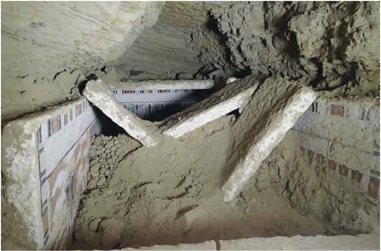
FIG. 12. Structure 1164, chambre funéraire de Sabi associée au puits 1164 A: détail des linteaux brisés de la couverture.
