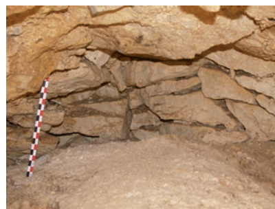
Plaquettes calcaires en place en fond d'excavation
