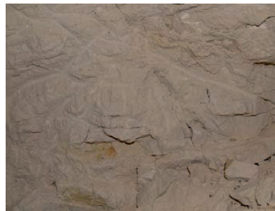
Traces d'outils sur la paroi d'une galerie
